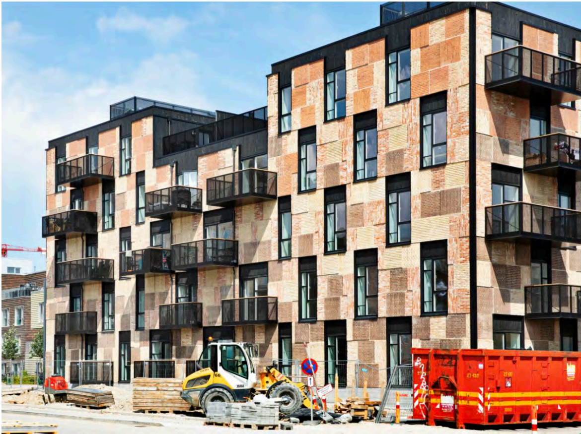
Figura 73: Fațada din cărămidă reciclată a unei clădiri de locuințe în Copenhaga, dezvoltator Lendager Group
