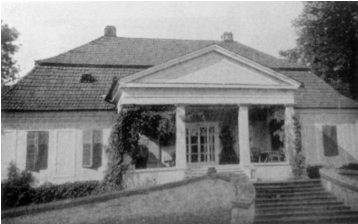
Figura 99: Fotografie arhivă conacul Torma
