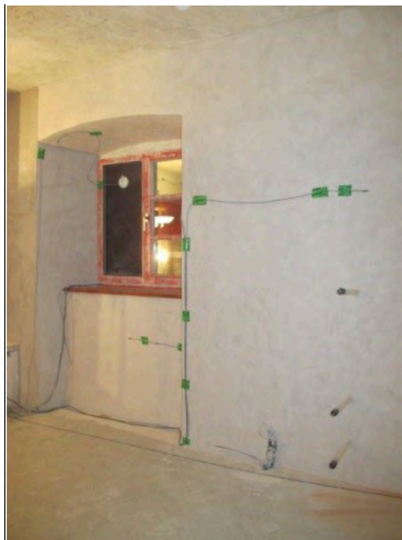
Figura 59: Senzori aplicați pe tencuială
