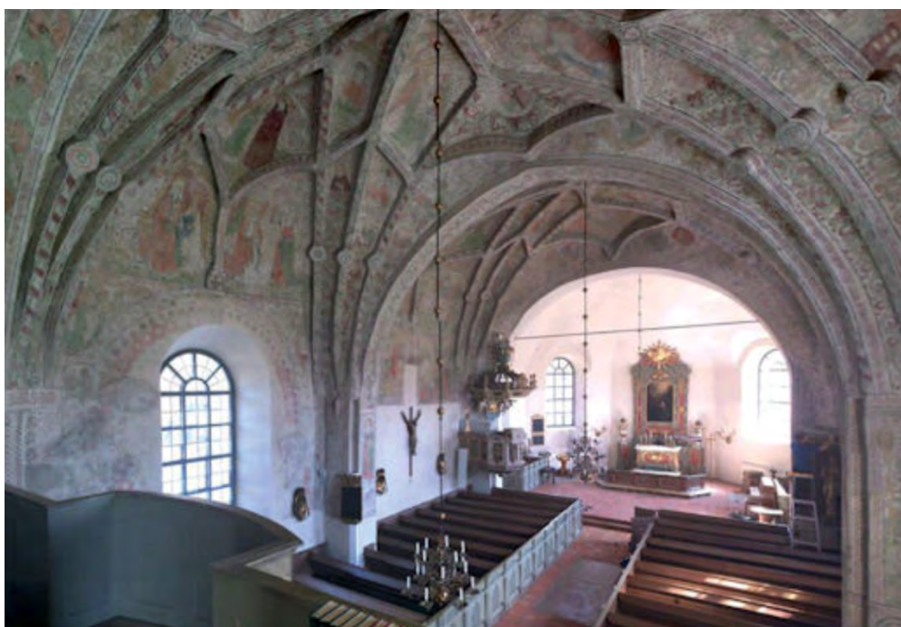
Figura 55: Biserica din Harg, Suedia. Aici a fost implementat sistemul de încălzire „invizibil”, cu suflante de aer cald în bănci, sistem dezvoltat în urma studiului preliminar asupra bisericilor medieval din Suedia
