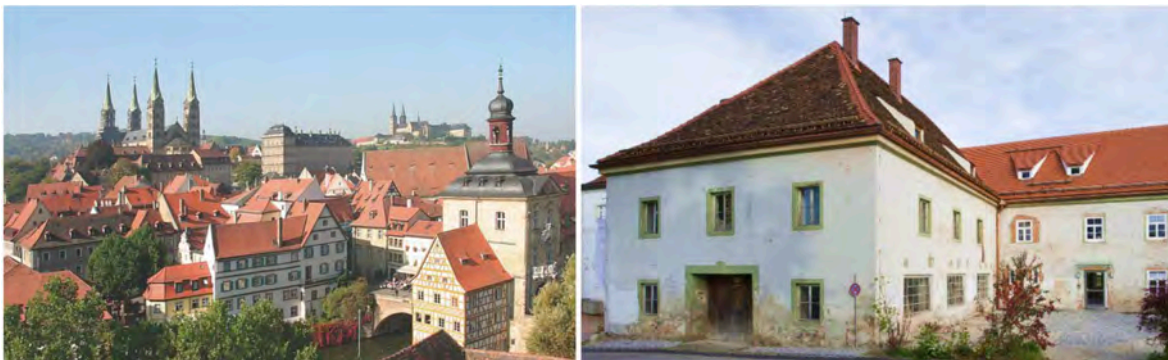
Figura 58: Mănăstirea benedictină din Bamberg, Germania. Aplicarea unui mortar izolan și monitorizarea comportamentului energetic al clădirii în timp, proiectul EFFESUS
