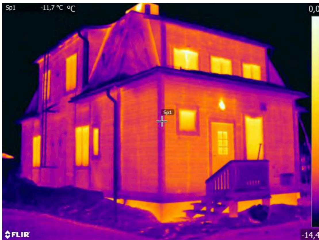
Figura 56: Studiu aprofundat al comportamentului energetic al clădirii
